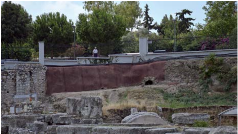
15 Αθήνα, Κεραμεικός, η προσωρινή στήριξη του πρανούς κάτω από την οδό Μελιδώνη το 2015 | Athen, Kerameikos, die vorläufige Hangsicherung im Gelände unterhalb der Melidoni-Straße 2015
