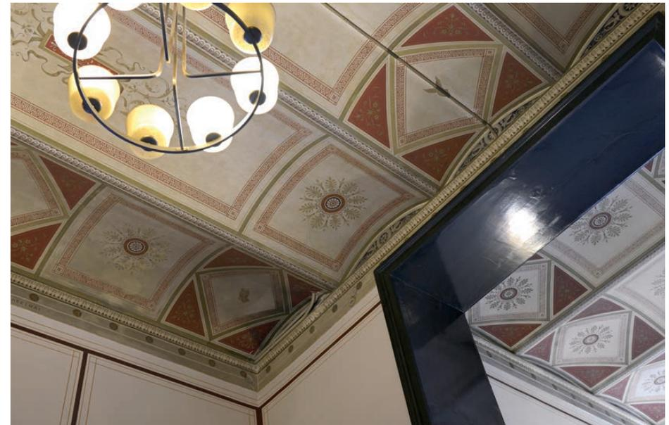
41 Ausschnitt zweier Decken mit Preuischen Kappen im Foyer und im Treppenhaus. Die Kappen sind zur Entlastung der Mauern unterschiedlich ausgerichtet.
