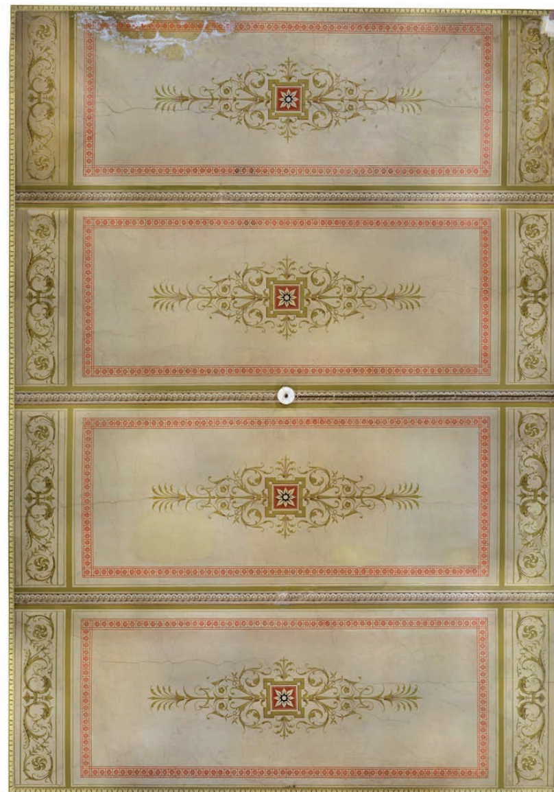
63 Η φωτογραμμετρική αποτύπωση απεικονίζει την οροφή, με τις φθορές της, σε έναν από τους παράπλευρους χώρους της Βιβλιοθήκης.
