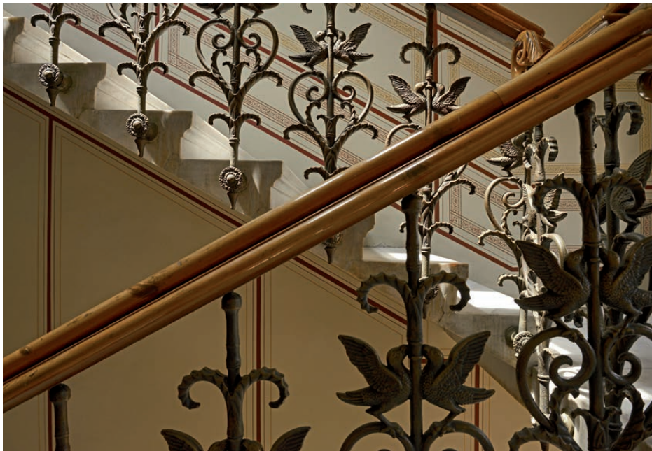
42 Λεπτομέρεια της μαρμαρίνης κλίμακας και του κιγκλιδώματος
