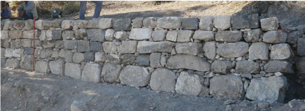
Das Errichten der Mauern erfolgt durch sorgfältiges Stapeln von möglichst großen Steinen. Idealerweise haben die Steine eine rechteckige Form. In die Zwischenräume der großen Steine werden kleinere Steine eingefügt.
