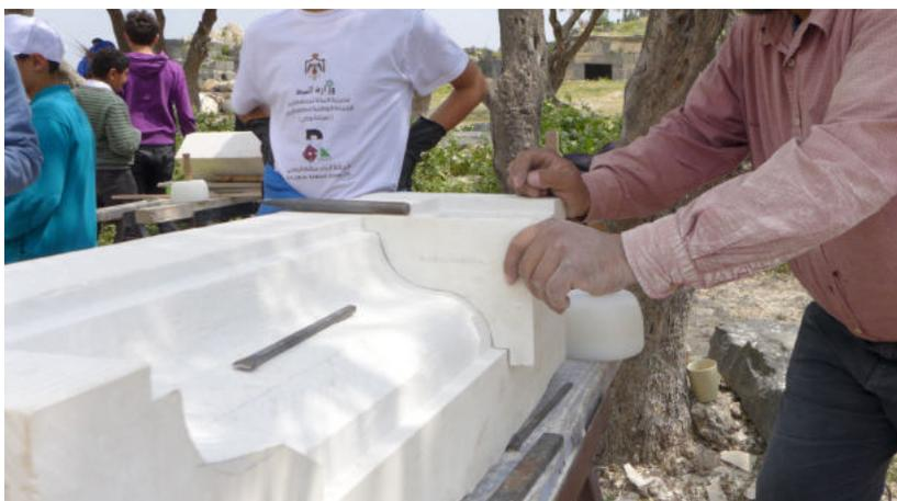
Zum Abschluss der Arbeiten müssen die Profile mit der Konterschablone überprüft und gegebenenfalls nachgearbeitet werden.
