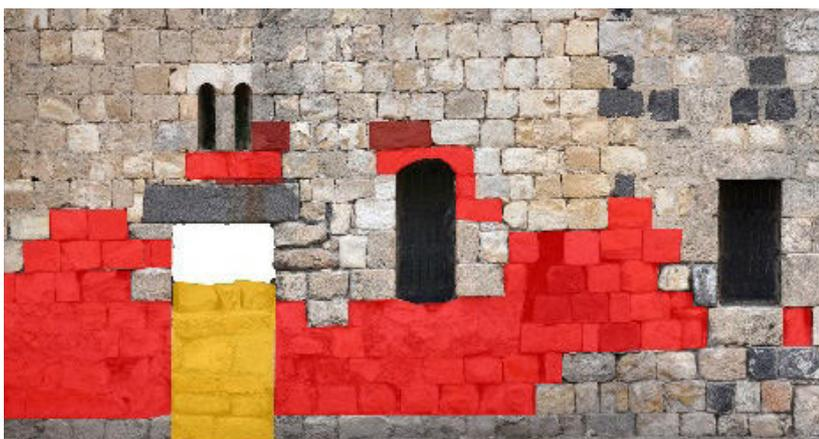
Grundlage der Sanierung sollte zunächst eine Übersicht über die Schäden sein, eine Schadenskartierung (hier in rot schadhaftes Mauerwerk; in gelb zugesetzte Türöffnung). Ausgehend von der Übersicht können die Maßnahmen geplant und kalkuliert werden. Im Gegensatz zur Fugensanierung werden bei der Mauerwerkssanierung Steine ausgetauscht oder teilweise entnommen und wieder neu vermauert.
