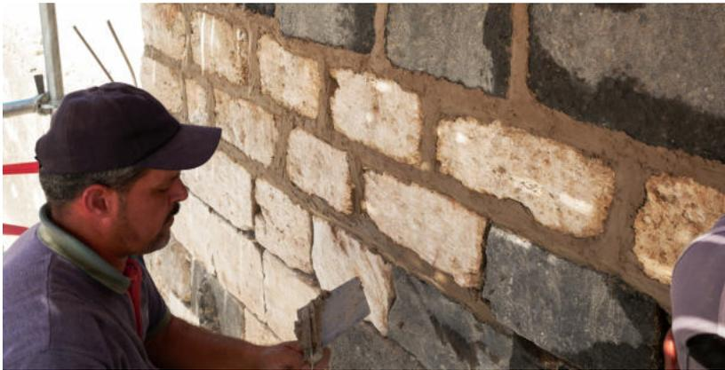
**(3)** Der Fugenmörtel wird mit einer feinen Fugenkelle tief in die Fugen gedrückt. Der Mörtel wird etwas höher und breiter als die Oberfläche der Steine aufgetragen.
