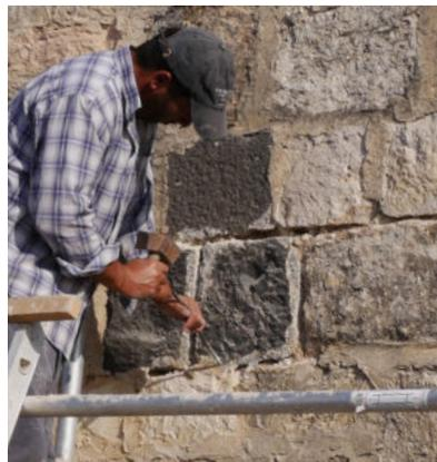
**(1)** Die Fugen müssen zunächst so tief wie möglich gereinigt werden. Oft können sie einfach ausgekratzt oder ausgeblasen werden.
