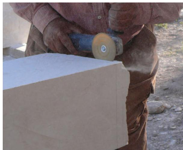
Der kleine Winkelschneider (125 mm) eignet sich besonders für das genaue Schneiden von Kanten.
