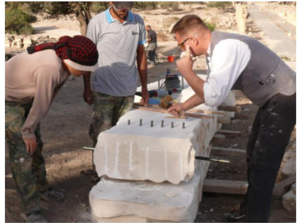
**(2)** Die Keile werden in mehreren Durchgängen nacheinander, jeweils mit einem Hammerschlag, in den Stein getrieben. Beim Schlag auf die Keile ist auf das Geräusch zu achten. Solange der Ton hell klingt und nachklingt, ist der Stein intakt. Sobald das Geräusch beim Schlag auf die Keile deutlich dumpfer klingt, ist der Stein gebrochen.
