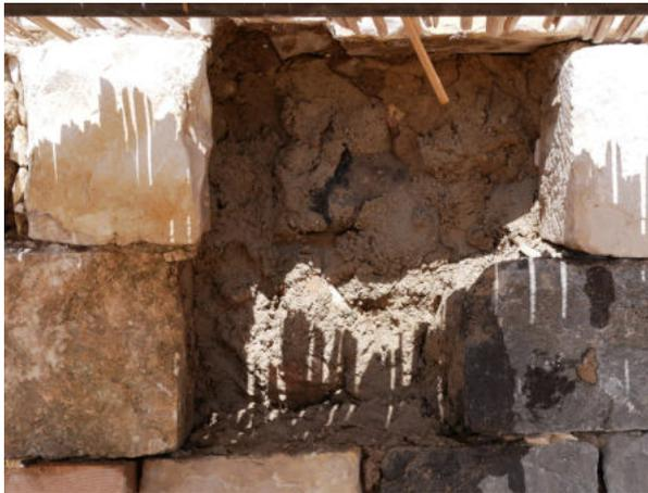
**(4)** Bevor die Mauerwerkssteine wieder eingesetzt werden können, muss das Mauerwerk vorbereitet werden. Wenn möglich, sollte der Hohlraum mit Mörtel ausgeworfen werden.
