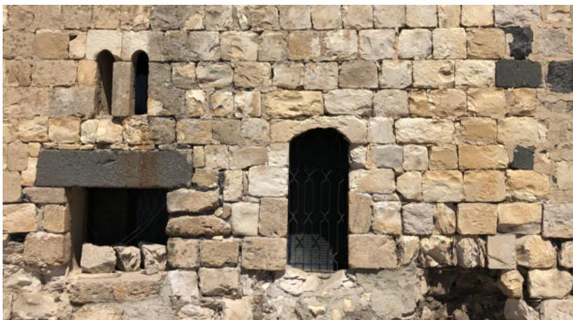
Die meisten Mauern zeigen nicht nur einen, sondern gleich mehrere Schäden. Zu den Schäden zählen neben den offenen Fugen meist Setzungen, verwitterte und ausgebrochene Steine. Außerdem können schlecht ausgeführte Reparaturen zu Schäden oder einem unbefriedigendem optischen Zustand führen.
