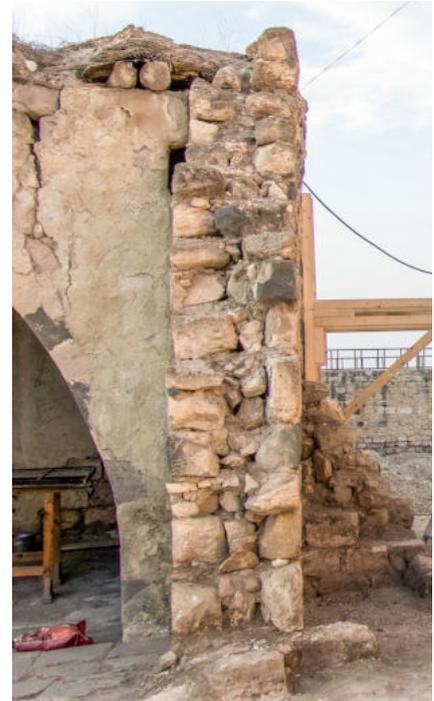
Das Mauerwerk ist zweischalig und besitzt ein Füllmauerwerk aus kleinen Steinen und einem Erdmörtel.
