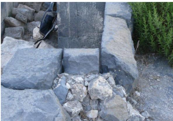
Der Aufbau (zweischalig) der antiken Mauerwerke ist bei vielen Bauwerken von Gadara vergleichbar. Sie bestehen aus einer inneren und einer äußeren Schale und einem Mauerwerkskern.
