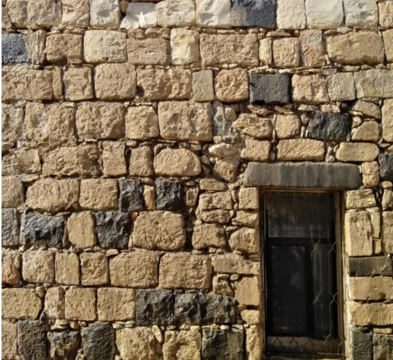
Die Wände bestehen größtenteils aus wiederverwendetem Material und weisen durchgehende horizontale Lagerfugen auf. Die Steine sind regelmäßig behauene Kalk- und Basaltsteine. Kleinere Hohlräume in den Fugen sind mit flachen Steinen ausgezwickelt. Über den Fenster- und Türöffnungen befinden sich monolithische Stürze.
