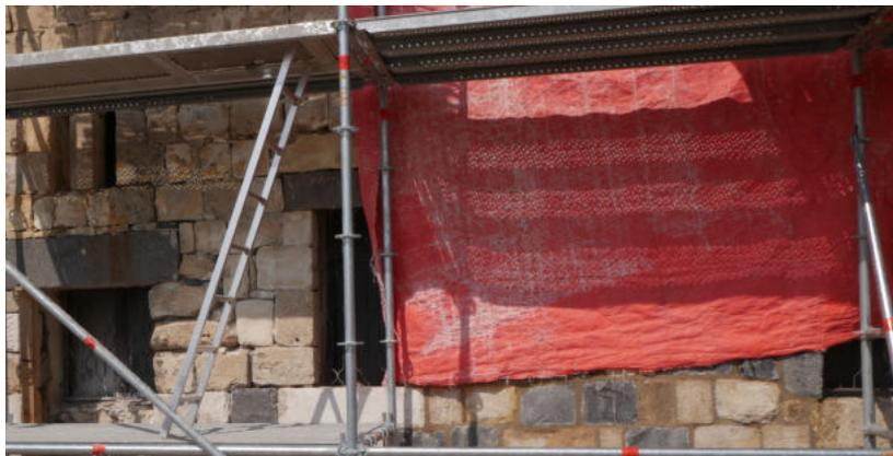
**(!)** Außerdem sollte vermieden werden, dass die Sonne direkt auf den Mörtel scheint. Wenn nötig, muss der verfugte Fassadenbereich abgehängt werden.
