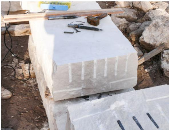
**(3)** Wenn die Keile richtig gesetzt sind und der Stein keine Störung aufweist, bricht der Stein senkrecht zur Oberfläche.
