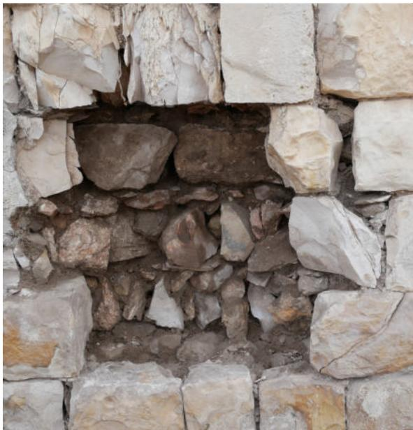
(2) Nach dem Rückbau der geschädigten Steine müssen auch lose Mörtelreste und andere lose Teile entfernt werden.
