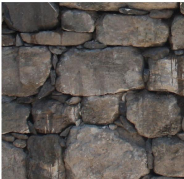
**(3)** Nach dem Versetzen der Steine können kleinere Zwischenräume noch mit kleinen Steinen ausgezwickelt werden.
