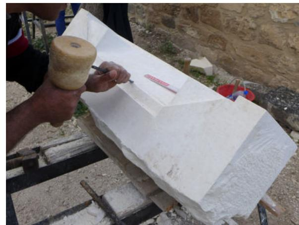
Die Arbeit an nach innen abgewinkelten Profilen erfolgt mit Hilfe von **Schablone, Kontraschablone, Winkel und Maßband.**
