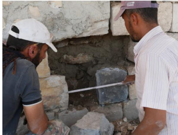
**(!)** Im Sockelbereich kann es ratsam sein, geschädigte Kalksteine durch Basaltsteine zu ersetzen.
