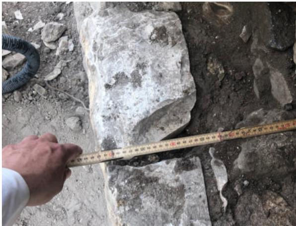
**(3)** Anschließend müssen passende Steine für die Fehlstellen gefunden werden. Sie sollten möglichst tief ins Mauerwerk einbinden.
