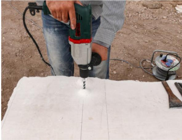
**(1)** Im ersten Schritt werden Löcher in regelmäßigen Abständen entlang der gewünschten Bruchlinie gebohrt und die Keile eingesetzt.
