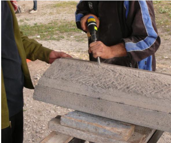
Mit Drucklufthammer und Spitzeisen wird der Bossen in diagonalen Bahnen abgearbeitet.
