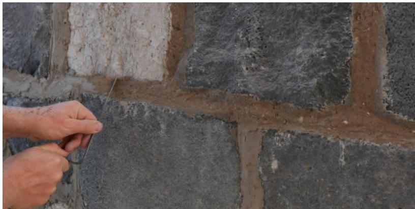
**(5)** Nach zirka 24 Stunden, wenn die Oberfläche des Mörtels noch nicht ganz ausgehärtet ist, kann die obere, versinterte Mörtelschicht abgekratzt werden.
