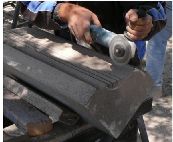
Kleine parallele Schnitte ermöglichen, dass das Gestein anschließend mit einem Spitzzeisen leichter abgetragen werden kann. Die Arbeit mit dem Spitz- und Zahnzeisen benötigt dadurch weniger Zeit.
