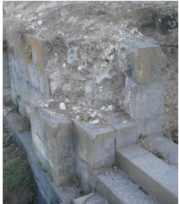
Mauerwerke aus Basalt zeigen keine Schäden des Natursteins. Der Zerfall einer Mauer beginnt damit, dass sich ein Quader aus der Wand löst. Anschließend zerfällt das Füllmauerwerk und nach und nach stürzen weitere Quader aus der Wand.
