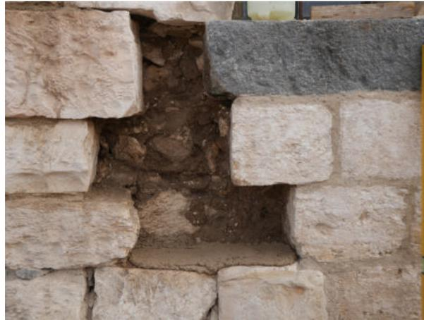
**(5)** Vor dem Einsetzen der Steine muss ein Mörtelbett auf die Lagerfuge aufgetragen werden. Das Mörtelbett der Lagerfuge sollte so hoch sein, dass das Fugenbild zu den benachbarten Steinen passt.
