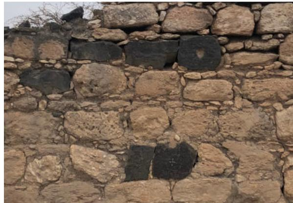
Besonders gefährdet sind Mischmauerwerke, die mit kleineren Steinen ausgezwickelt sind. Eine Fugensanierung dieser Mauern ist besonders wichtig.
