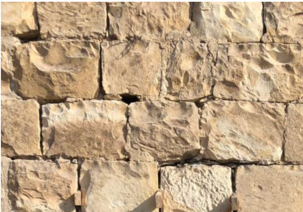
Je unregelmäßiger das Mauerwerk und die Mauersteine sind, umso wichtiger ist der Zustand der Fugen für die Standsicherheit.
