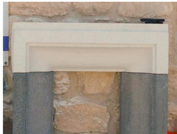
Die einfache Wiederkehr kann an beiden Seiten angezeichnet werden. Bei einer zweifachen Wiederkehr muss das mittlere Profil ohne Schablone konstruiert werden.
