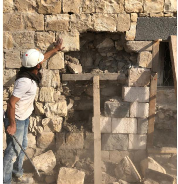
Da die Sicherheit höchste Priorität besitzt, müssen immer Bauhelme getragen werden. Wenn nötig, müssen die Bereiche, an denen gearbeitet wird, auch abgestützt werden.
