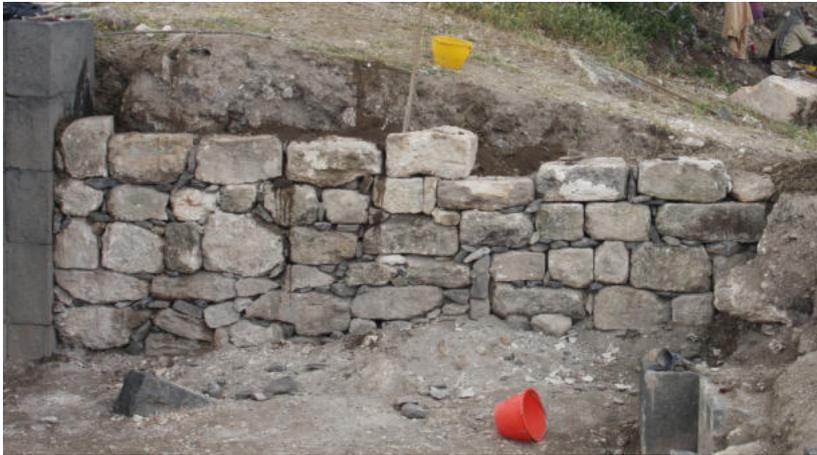
Die Stabilität der Mauer kann erhöht werden, wenn hinter die Mauerschale Steine geschüttet und diese mit Erde verdichtet werden.
