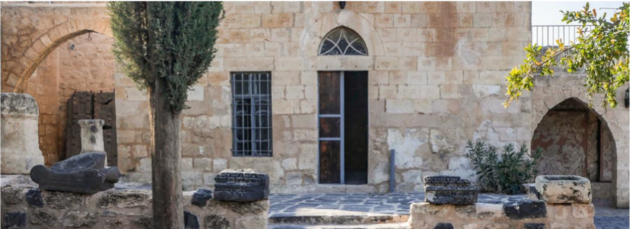
تم استخدام الحجارة (المنحوتة أو المطروقة) المحفور بدقة مربعة الشكل وتم كسرها خصيصاً لإنشاء البناء. تم إعادة استخدام بعض المكونات من البازلت، كما أن عتبات النوافذ مصنوعة من الكلس.
