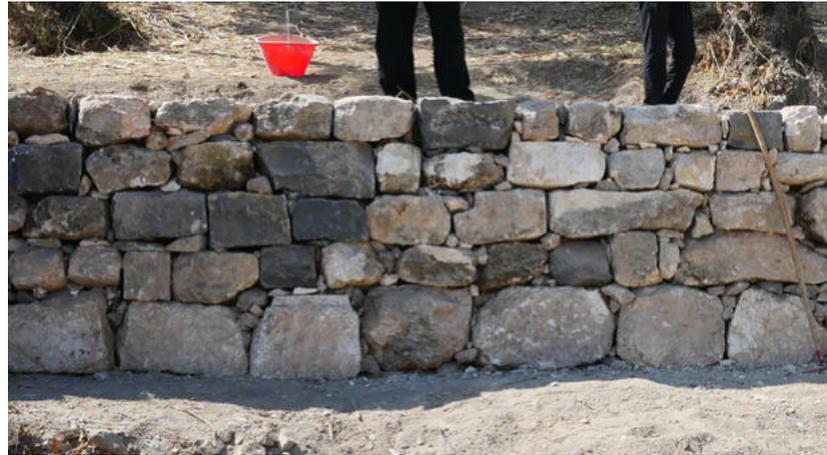
يجب أن تتكون الطبقة العلوية من أحجار كبيرة بشكل خاص. ومن الأفضل أن تكون هذه الأحجار مربعة الشكل. لضمان عدم سقوط الحجارة العلوية من الجدار، يجب أن تكون هذه الحجارة مدفونة بعمق لا يقل عن عمق الجدار بأكمله.
